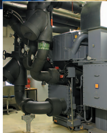
Auf knappstem Raum untergebracht: Erdgasgefeuertes BHKW-Modul von Deutz Power Systems und zweistufige Broad-Absorptionskälteanlage von Gasklima
